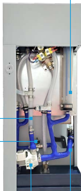
Pompe de drainage motorisée
