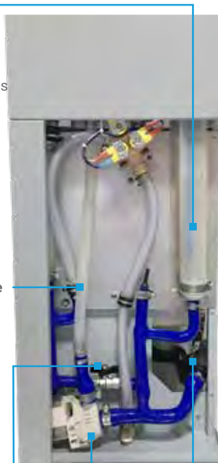
Pompe de drainage motorisée
